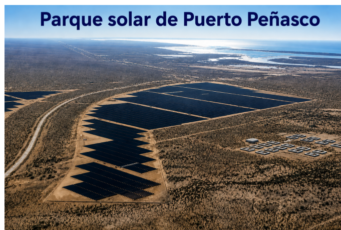
Figura 3. Parque solar Puerto Peñasco.
